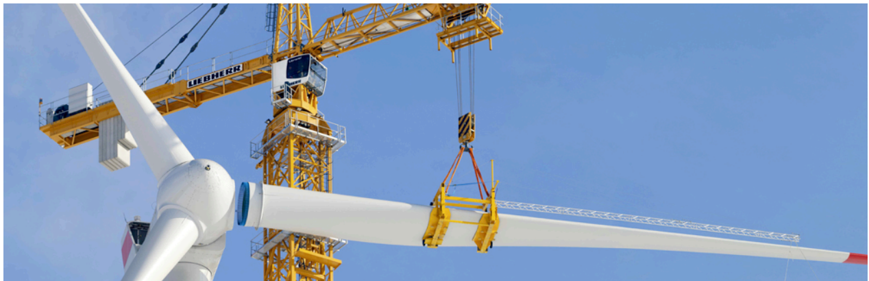
Liebherr 630EC-H70 Crane
